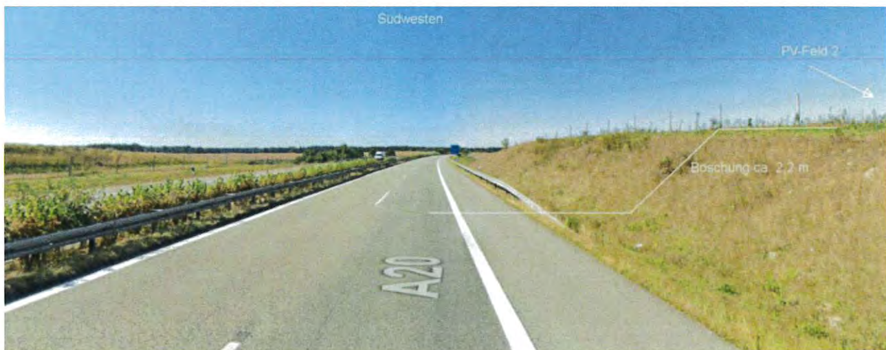
Bild 4.1.3: Böschung entlang der A20 auf ca. 300 m (Quelle: Google StreetView, August 2022, Ausschnitt)
